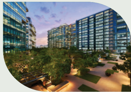
Gera Commerzone Kharadi, Pune
